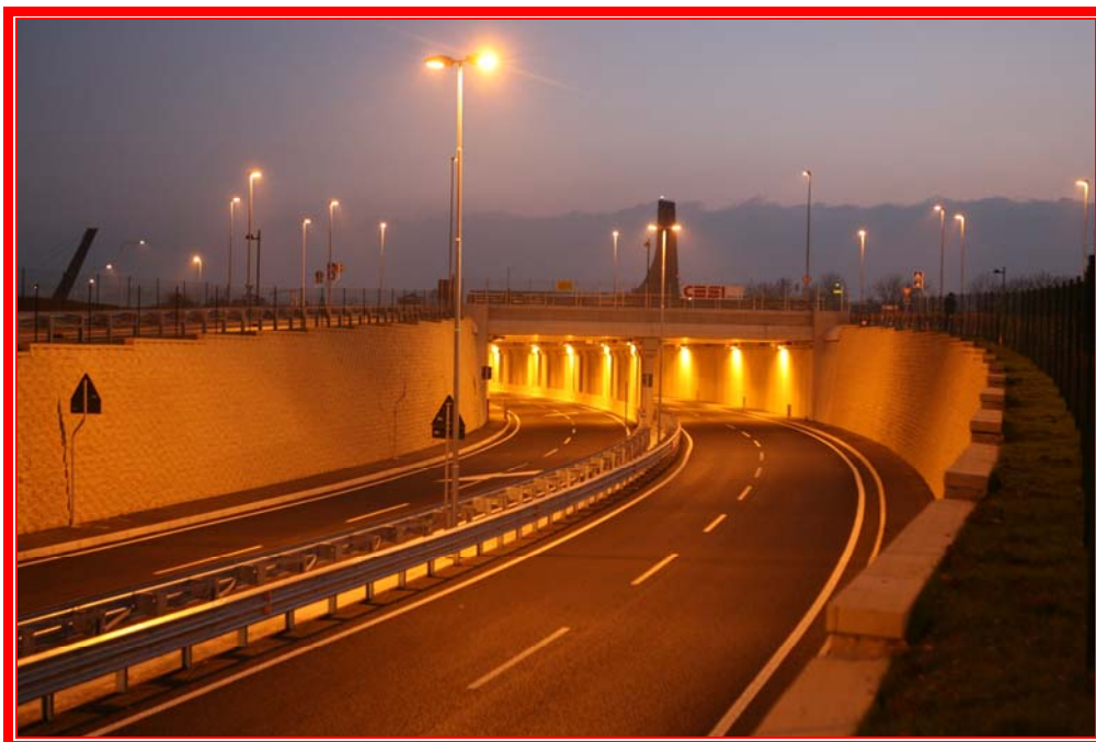
Nuovo asse attrezzato via Costituzione – Imola
