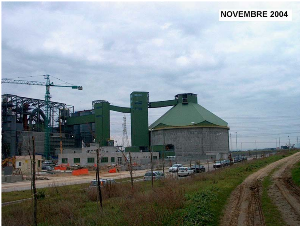
Cement plant in Montalto di Castro (Roma, ITA)
